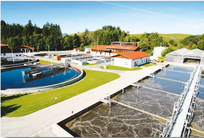
Abb. 1: Mechanisch-biologisch-chemische Kläranlage des Abwasserzweckverbandes Füssen für 70.000 Einwohnergleichwerte. Die Dächer im Vordergrund gehören zur solaren Schlamm-trocknungsanlage.
